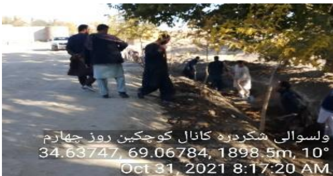
پروژه پاک کاری کانال ولسوالی شکرده
