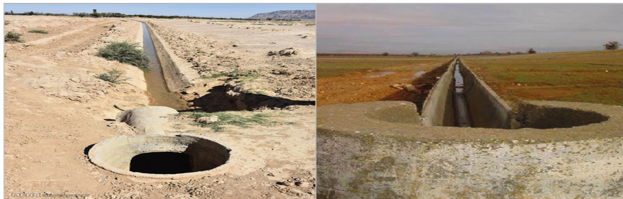
شکل (۱۱) نمایش چاه‌های تغذیه کننده برای انتقال آب به زیرزمین
