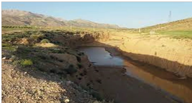
شکل (۱۰) نمایش گودال حفر شده برای ذخیره و جذب شدن آب
