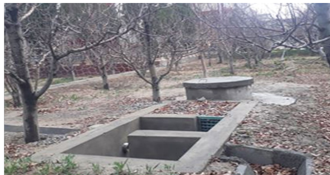
شکل (۸) نمایش چاه تغذیه مصنوعی آب‌های زیرزمینی وزارت آب و انرژی
